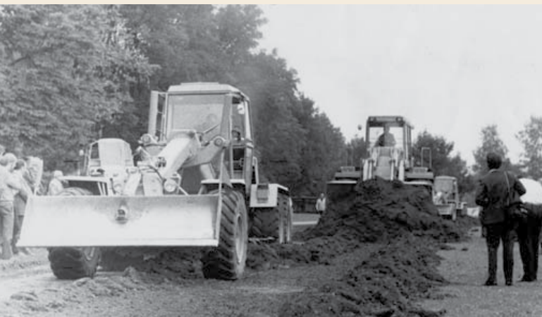
Beginn der Aushubarbeiten mit Maschinen durch Fa. Frisch
