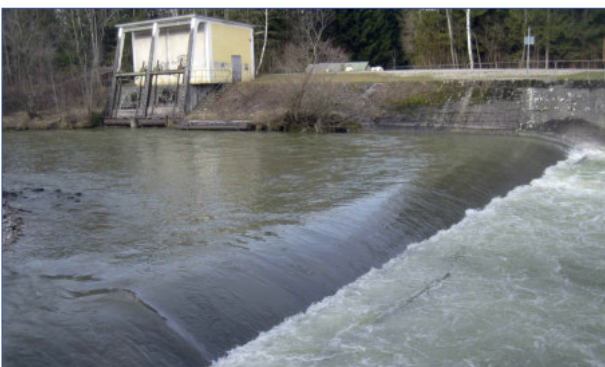
Abgerundetes Steilwehr, bei allen Wasserständen nicht befahrbar.
