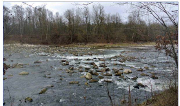
Absturz, umgebaut in eine Sohlengleite.
