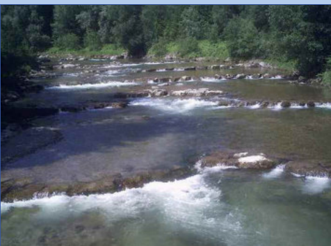
Ehemaliges Steilwehr auf 500 m mit Querriegeln abge- stuft (Mangfall bei Grub).
