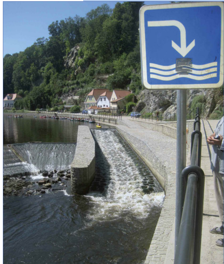
Foto links: Borstenfischpass am Wehr in Truchtlaching/Alz.
